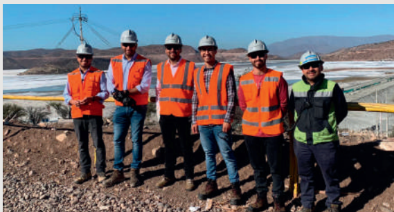
Planta Fotovoltaica construida sobre un depósito de relaves minero, de Anglo American.
