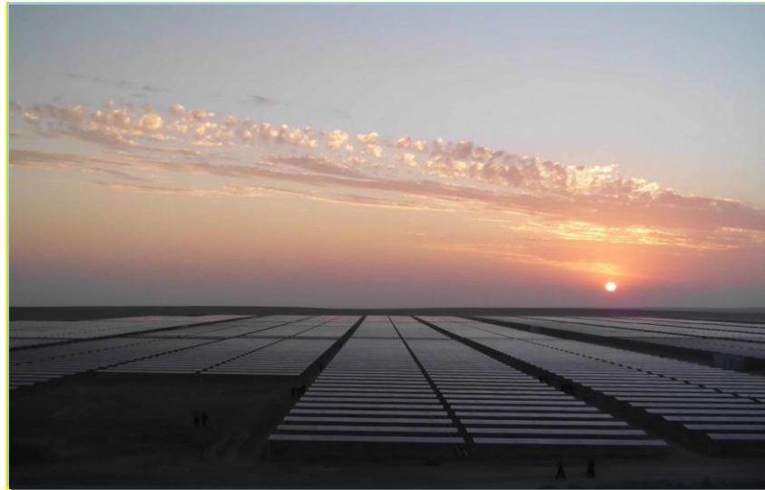
Figura N° 4: Planta solar fotovoltaica Pozo Almonte Solar (2 y 3), 25 MW de potencia nominal.
