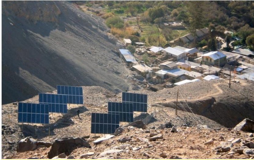
Figura N° 3: Planta solar fotovoltaica Huatacondo, 22,8 kW de potencia nominal.
